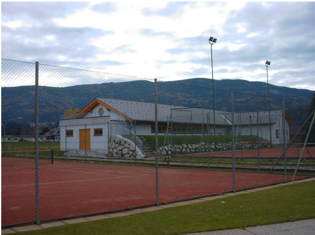
Bild der neu errichteten Gerätehütte mit angeschlossener Stockhalle und Zuschauertribüne
